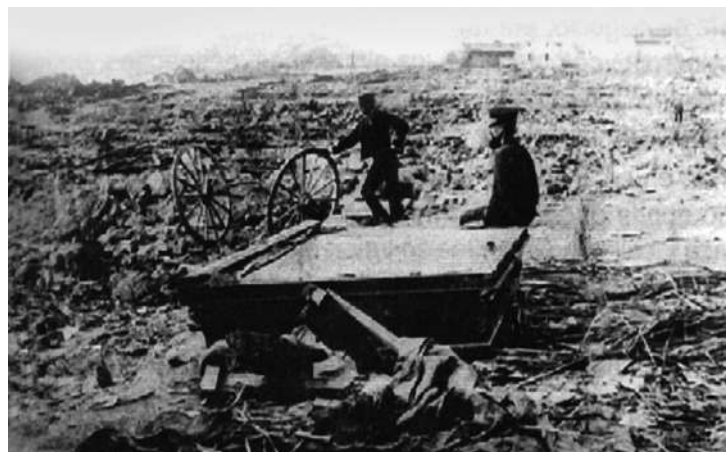
Illustration 7: Dégâts soufferts sur le Littoral Bolivien suite au raz-de-marée, 1877.
